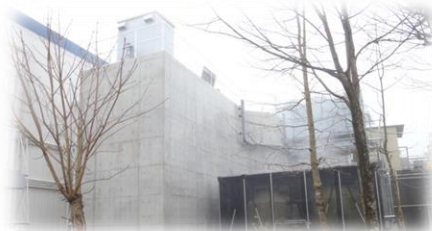
乳製品加工場排水処理施設 (平成25年4月納入・静岡県)
