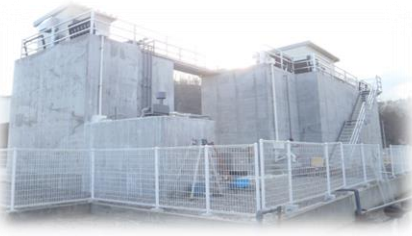
水産加工場排水処理施設 (平成27年9月納入・宮城県)
