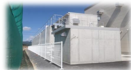
食品加工場排水処理施設 (平成25年5月納入・宮城県)
