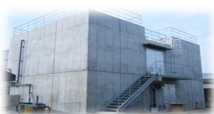
食品加工場排水処理施設 (平成20年8月納入・千葉県)
