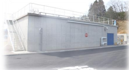
食品加工場排水処理施設 (平成25年4月納入・滋賀県)
