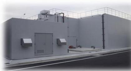
乳製品加工場排水処理施設 (平成27年1月納入・兵庫県)
